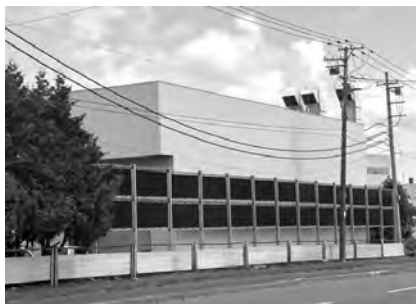
北海道車体 縦型太陽光パネル
