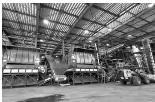
苫小牧支店 選別工場
