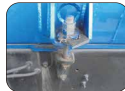
ボルトクッション材ずれ
