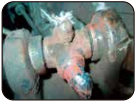
【ジャーナル破損】
