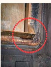
汚水パッキン劣化変形
