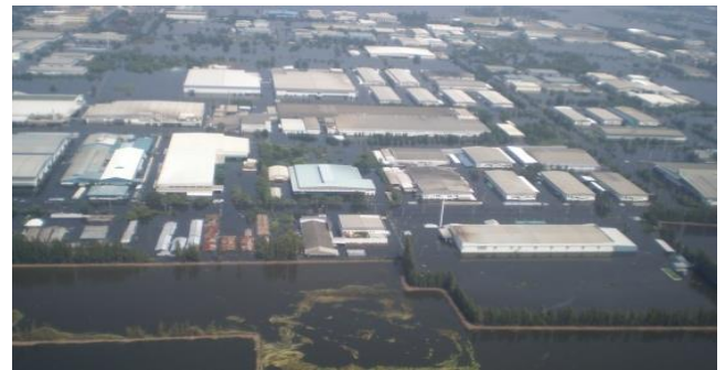
タイ国ロジャナ工業団地の浸水状況 (平成23年10月)
