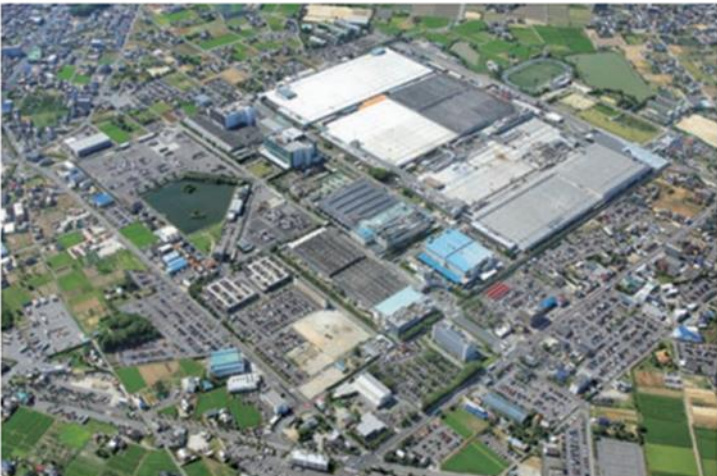
①本社・富士松工場(刈谷市) 面積 436,700㎡ Head Office : Fujimatsu Plant (Kariya, Aichi Pref.) Site area : 436,700m 2 〈主要製品〉 ヴォクシー、ノア、エスクァイア、アルファード、ヴェルファイア、 ランドクルーザー70 Main products : Voxy, Noah, Esquire, Alphard, Vellfire, Land Cruiser 70
